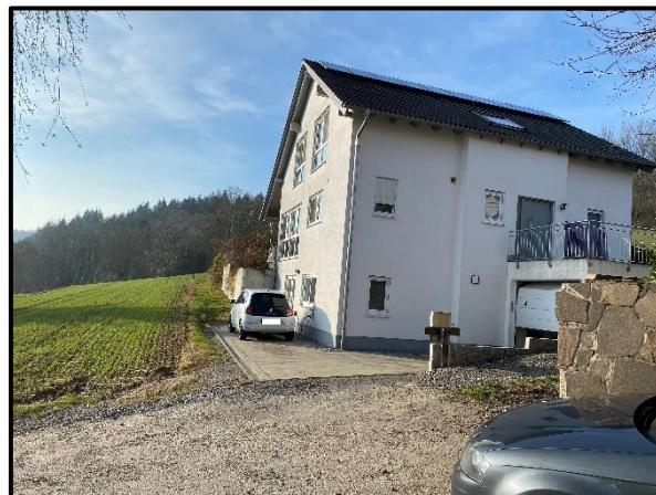
Wohnhaus auf Flurstück 17/67; Aufnahme von Südosten
